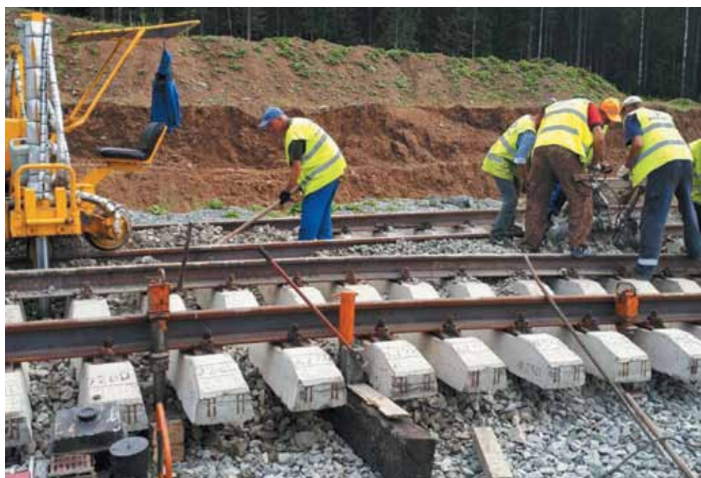
Строительно-монтажные работы по укладке верхнего строения пути участка Междуреченск — Тайшет
