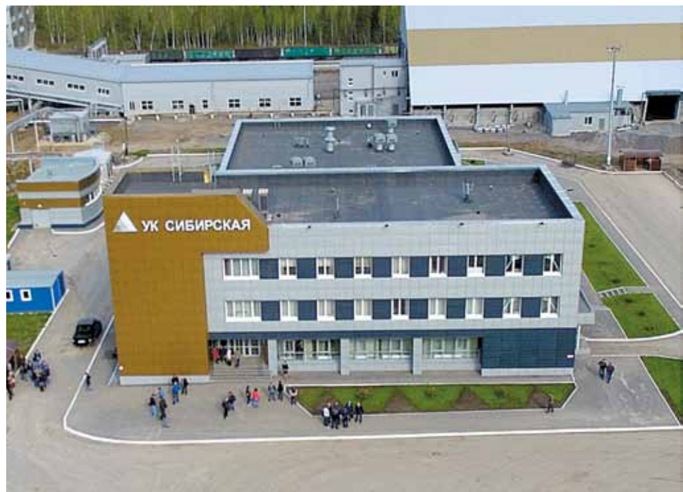
Шахта «Увальная» была построена с нуля и введена в строй в канун Дня шахтера
