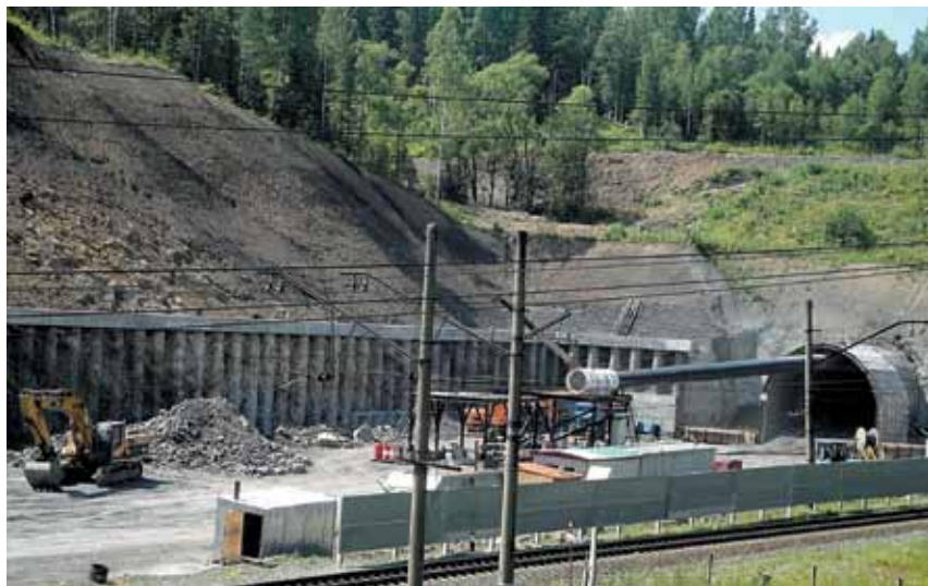
Реконструкция тоннеля Артышта — Томусинская
